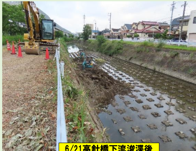
6/21高針橋下流浚渫後
