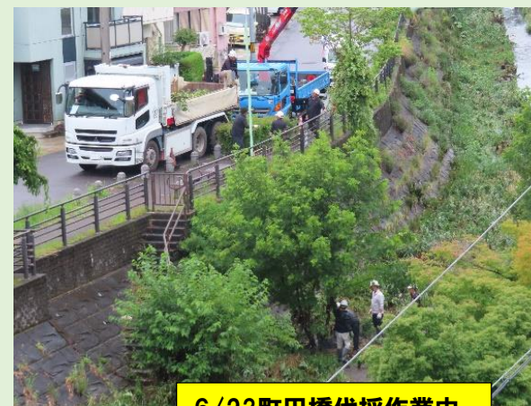
6/23町田橋伐採作業中
