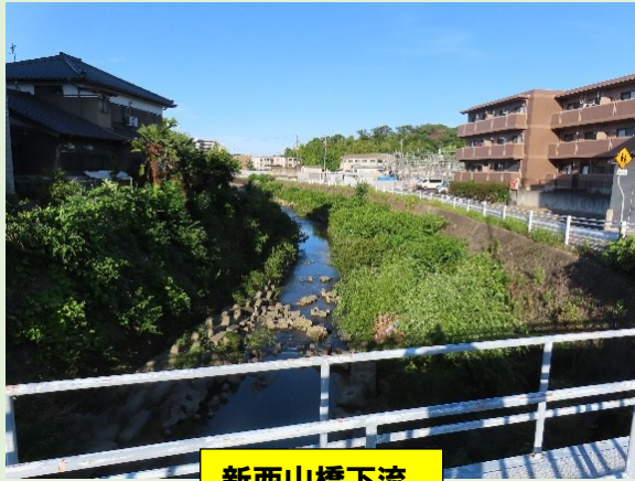
新西山橋下流
