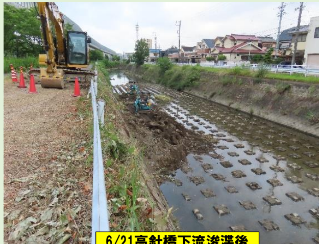
6/21高針橋下流浚渫後
