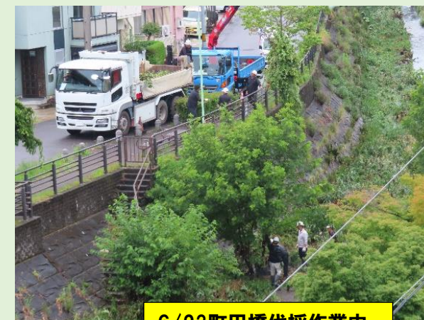
6/23町田橋伐採作業中
