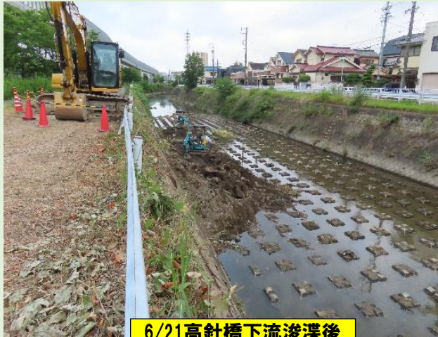
6/21高針橋下流浚渫後
