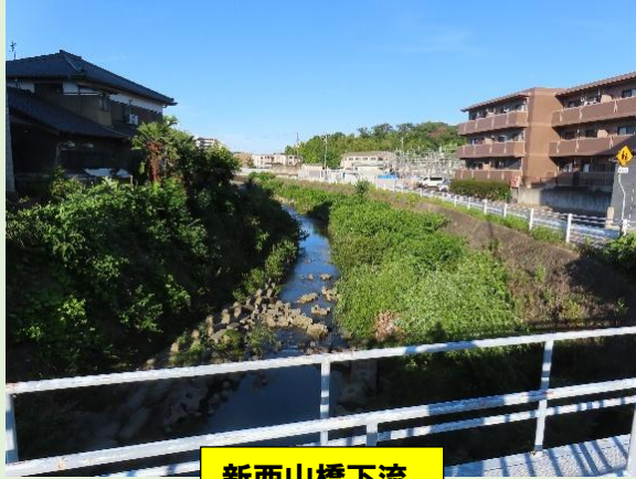
新西山橋下流
