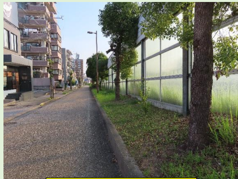
猪高台交差点北整備
