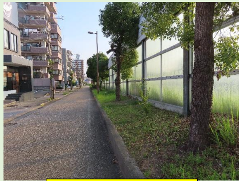
猪高台交差点北整備
